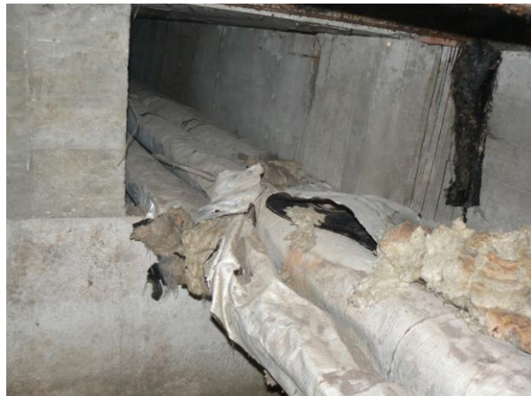
Obr.4 – Narušená tepelná izolácia potrubia
