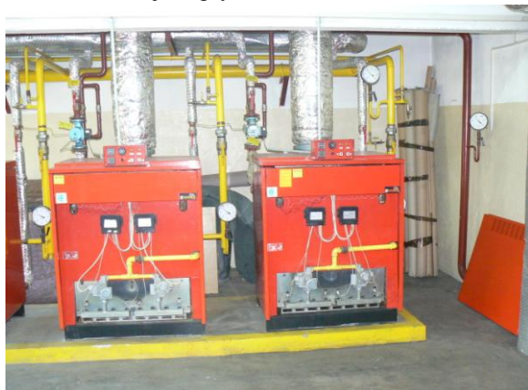
Obr. 1 – Existujúce plynové kotle
