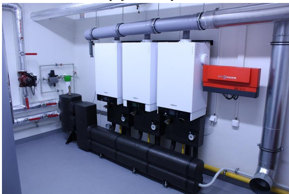
Obr. 5 – Vzorové zapojenie nových kotlov
