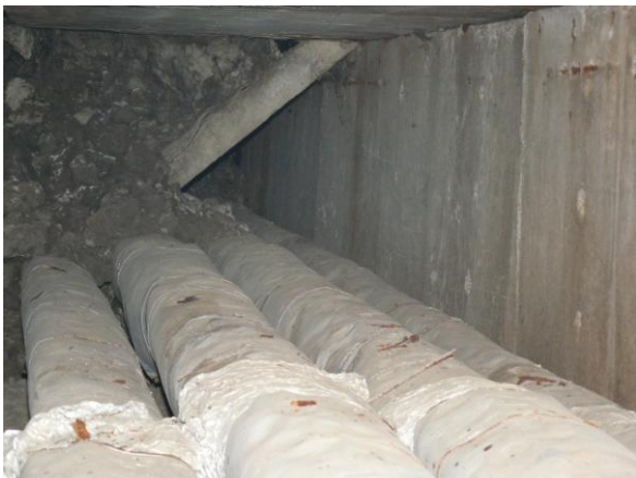
Obr.3 – Prepádnutie stropu kanálu
