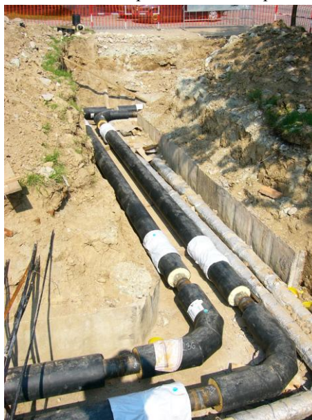
Obr. 7 – Vedenie predizolovaného potrubia
